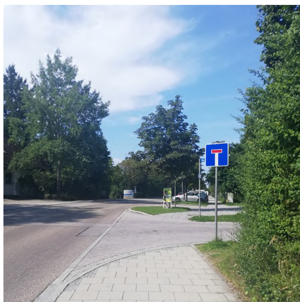
Abbildung 19: Beseitigung unnötiger Einschränkungen und Behinderungen des Radverkehrs durch verkehrsrechtliche Anordnungen (nicht durchlässige Sackgasse) am Beispiel Dornacher Straße
