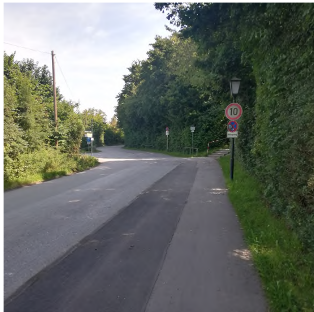
Abbildung 33: Einrichtung einer Fahrradstraße (mit Freigabe für den Kfz-Verkehr) in der Seestraße
