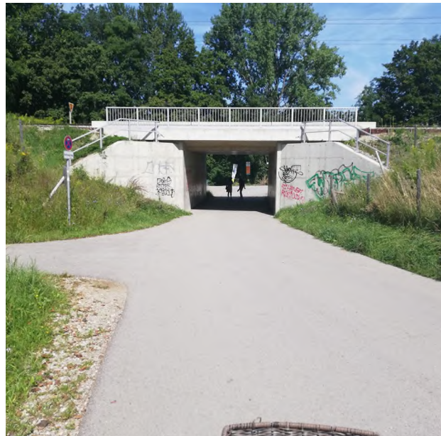
Abbildung 3: Bahnunterführung Franz-May-Straße Richtung Heimstettner Weg
